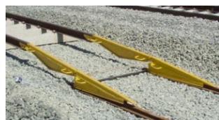
Pose longitudinale avec chemin de roulement (VPR)
